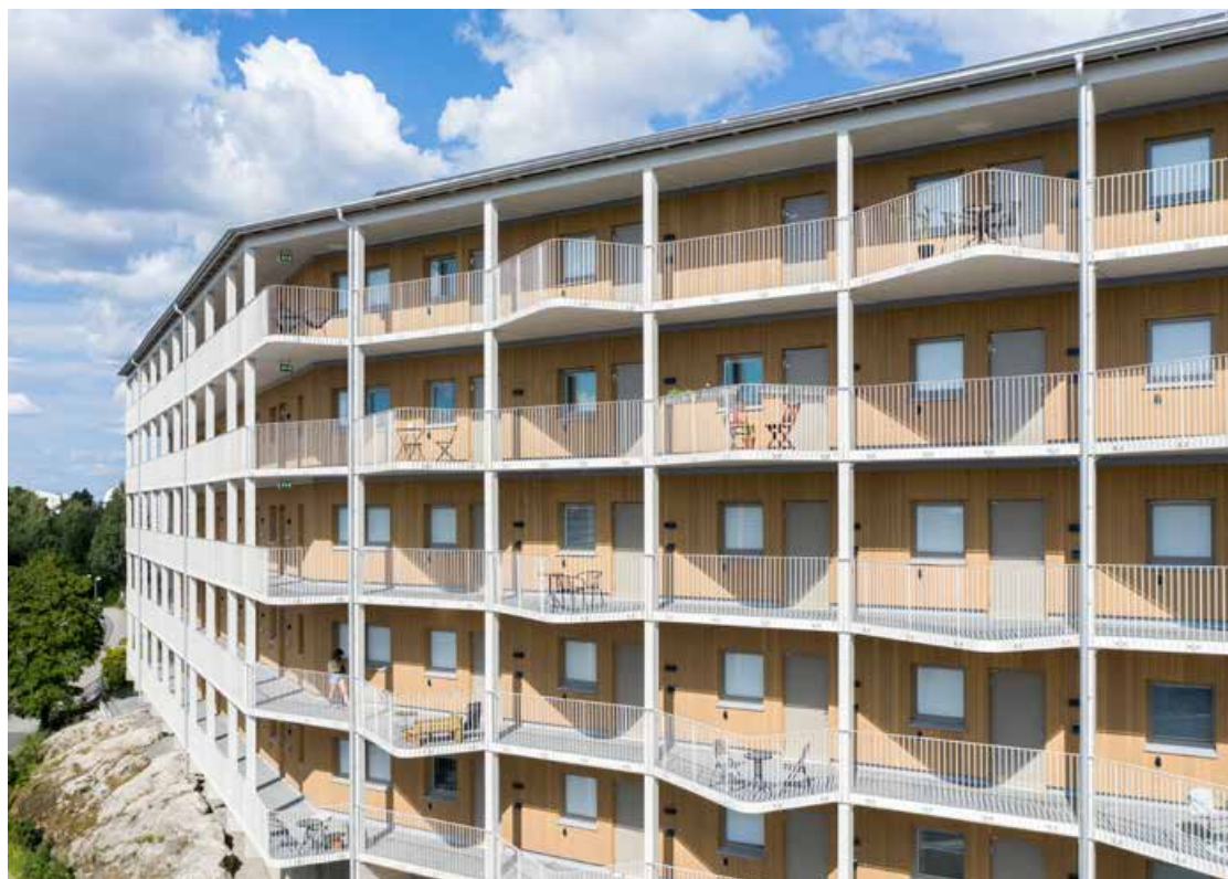
Sötmandeln 2, Sirapsvägen i Hökarängen, byggnadsår 2019/2020.
